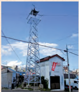
昭和2年築の住ノ江火の見櫓。地域住民により保存整備が進む。
